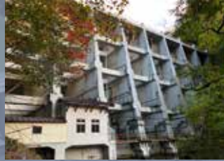
バットレスダム 丸沼ダム（群馬県片品村）
