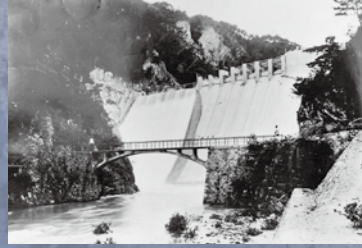
千苺ダム かさ上げ工事中 / 神戸市水道局
