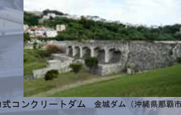
重力式コンクリートダム 金城ダム（沖縄県那覇市）
